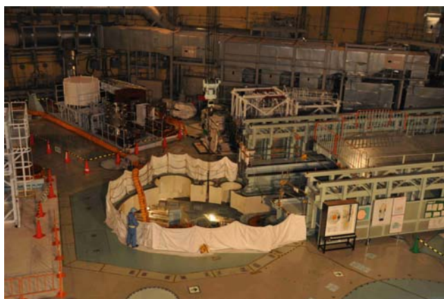
平成23年11月10日 14時30分頃の作業風景
