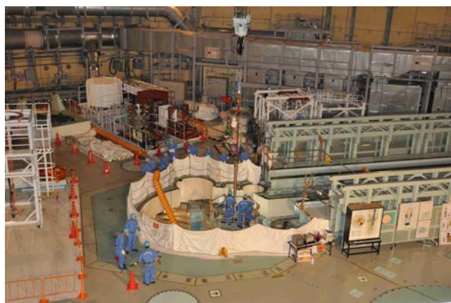
平成23年10月31日 14時30分頃の作業風景
