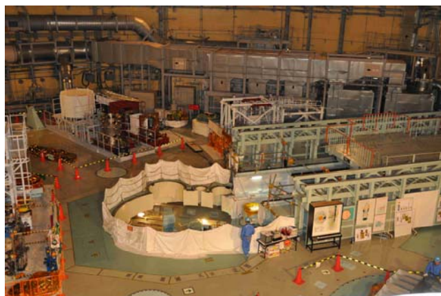
平成23年10月24日 14時30分頃の作業風景
