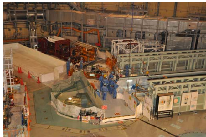
平成23年10月13日 14時頃の作業風景
