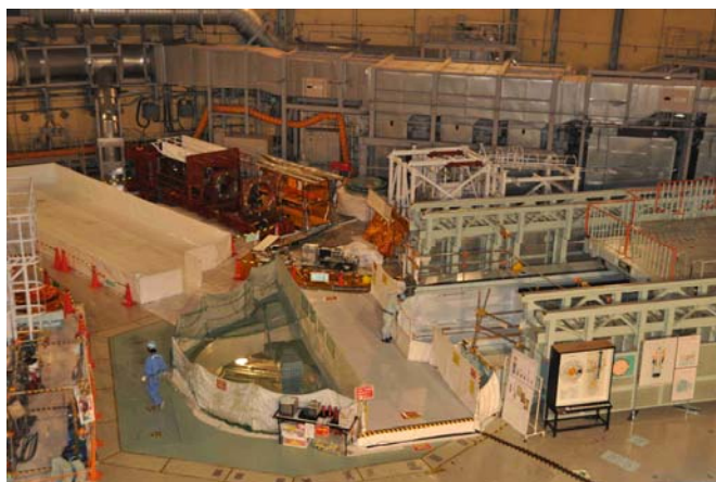
平成23年10月12日 14時30分頃の作業風景
