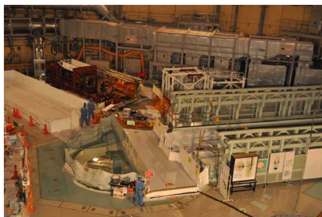
平成23年10月 4日 14時30分頃の作業風景
