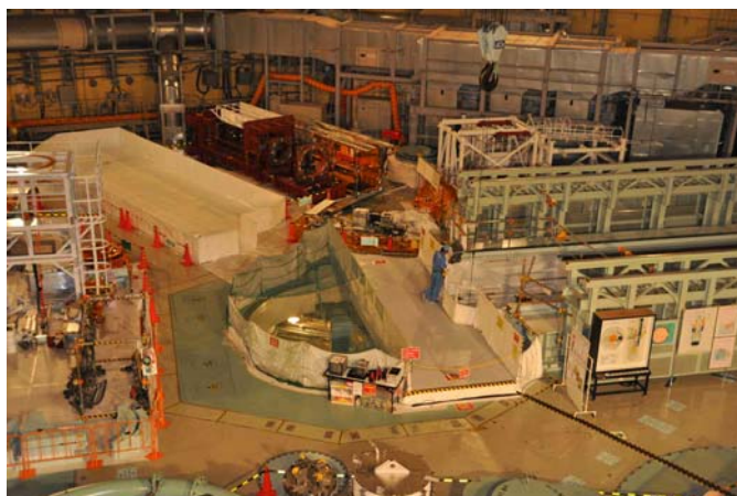
平成23年10月 3日 15時頃の作業風景
