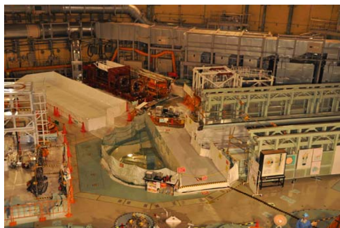
平成23年 9月29日 15時頃の作業風景
