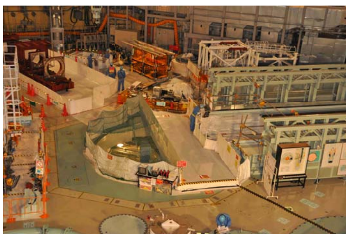
平成23年 9月20日 15時頃の作業風景
