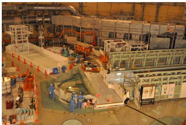
平成23年 9月 6日 15時頃の作業風景
