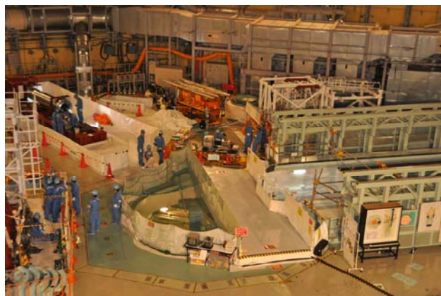
平成23年 9月 1日 15時頃の作業風景
