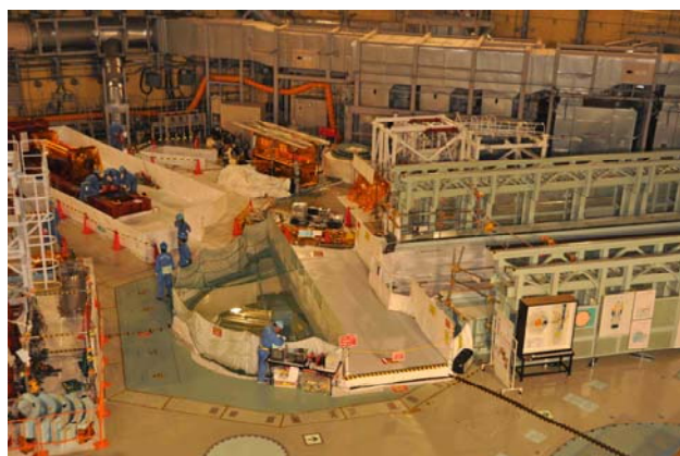
平成23年 8月31日 15時頃の作業風景
