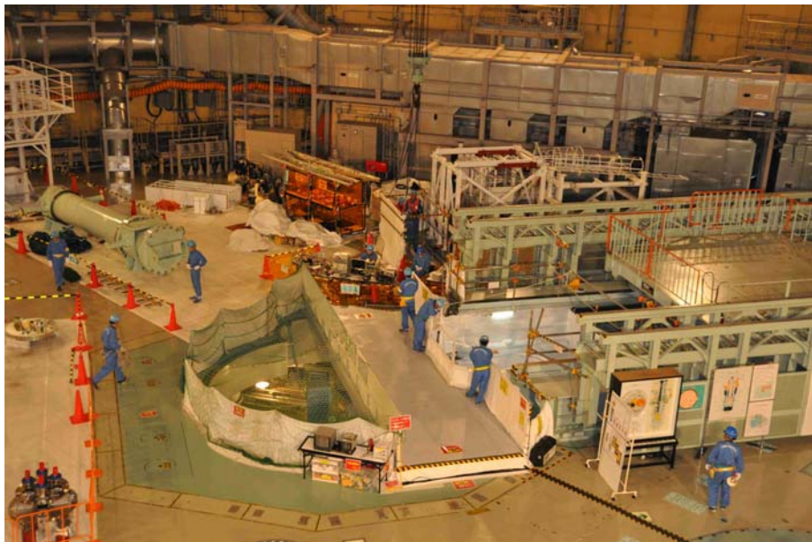
平成23年 7月 1日 14時頃の作業風景
