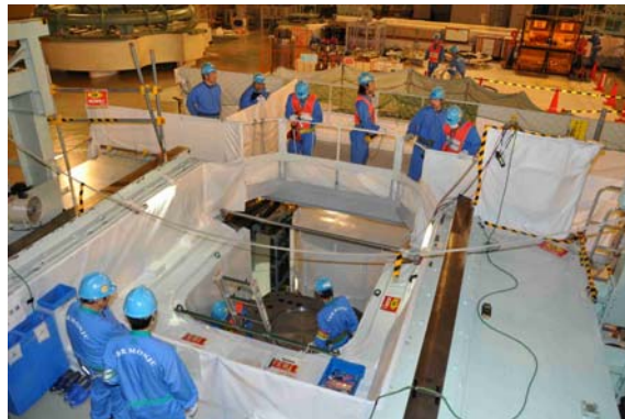
平成23年 5月26日 11時頃の作業風景
