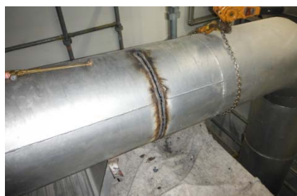
Aボイラー通風機ダクト ガス溶断箇所
