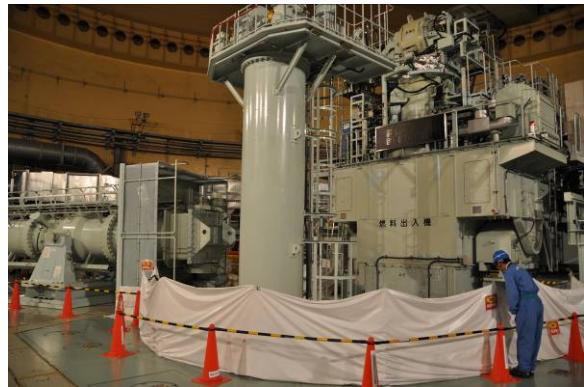
【燃料交換装置と燃料出入機】
