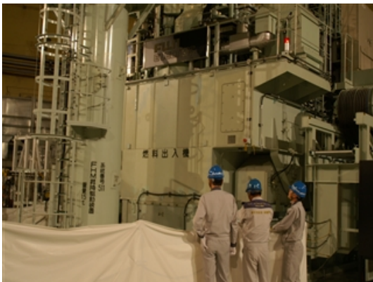
【燃料出入設備による作業】
