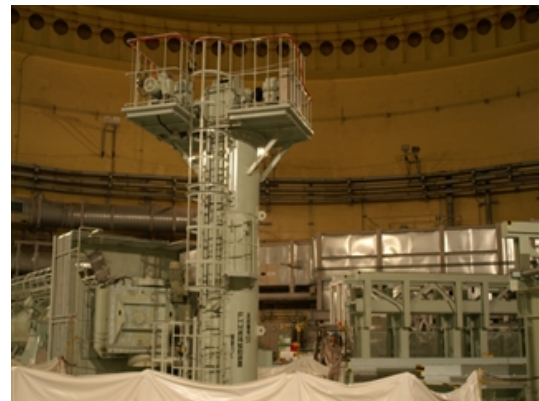
【燃料交換装置による作業】
