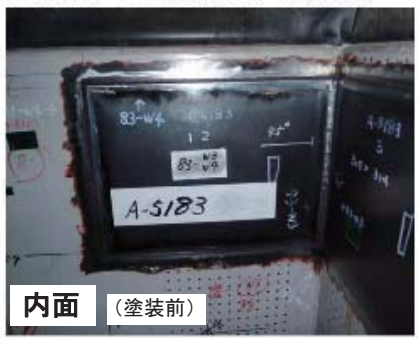
腐食孔部の当て板補修(すみ肉溶接)
