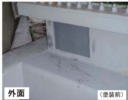
腐食孔部の当て板補修(コーキング材の施工)
