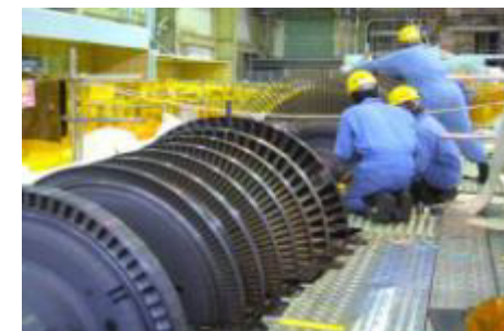
タービンロータの振れ測定状況
