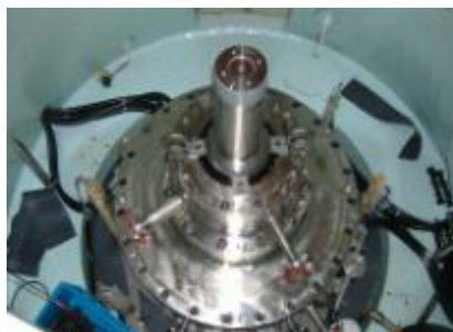
1次主循環ポンプ軸封部の点検状況
