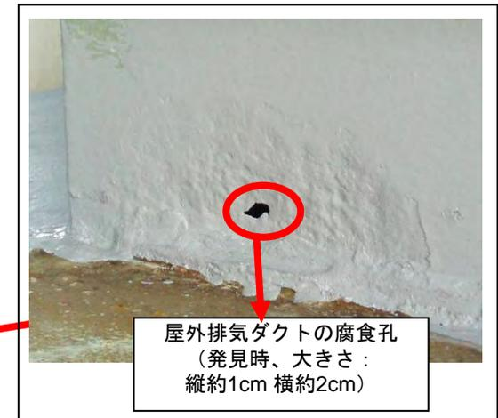
屋外排気ダクトの腐食孔
