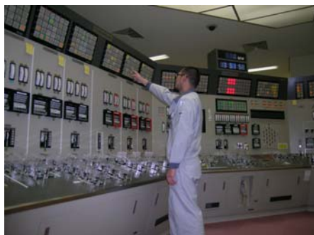
試験風景(中央制御室)
