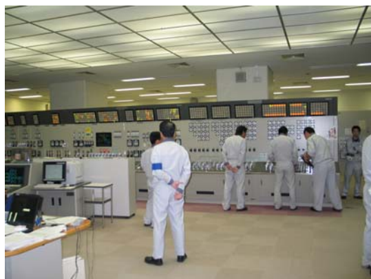
試験風景(中央制御室)
