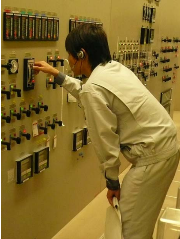
中央制御室内での電磁ポンプ起動操作
