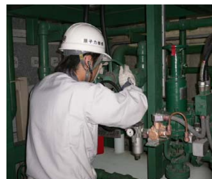
試験風景 (アルゴンガスによるタンク加圧操作)
