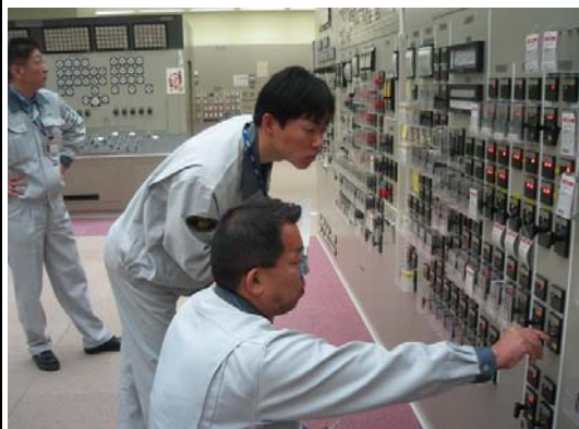
写真：確認試験実施状況
