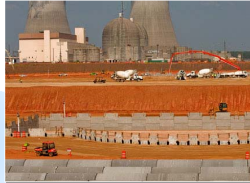
ボーグル3・4号基は米国最初の新世代の原子力発電所となる予定
