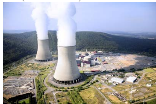
シヨー原子力発電所 - 2基 (1450 MW × 2)
