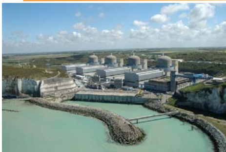
パリュエル原子力発電所 - 4基 (1300 MW × 4)
