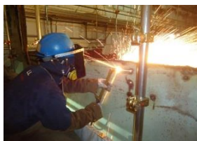
ガスリン切断
