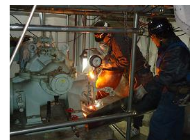
実機材解体検証
