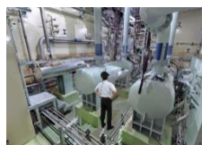
解体手順の合理化検証
