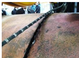
ダイヤモンドワイヤソー切断
