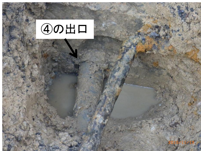
漏水箇所確認状況
