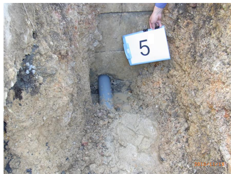
漏水箇所確認状況
