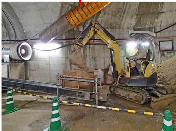
主立坑の坑底（深度500m）でベルトコンベアーに砂を投入し冠水坑道まで運搬
