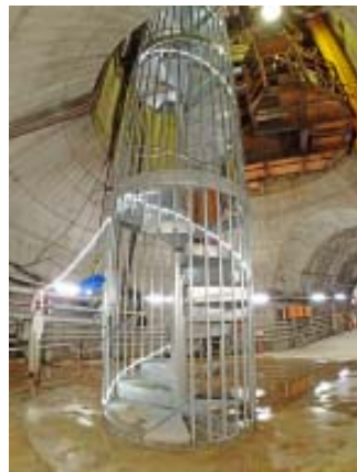
螺旋階段（深度500m 主立坑）
