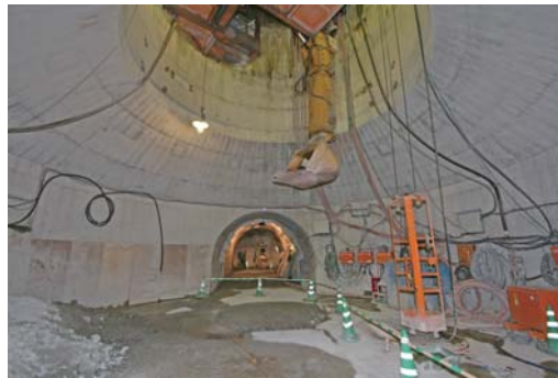
主立坑（深度500m）
