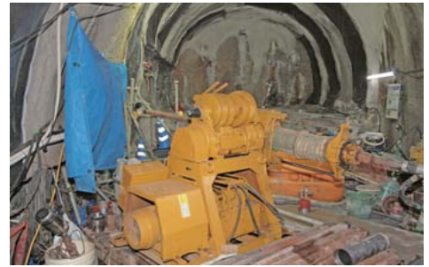
初期応力の測定のためのボーリング調査
