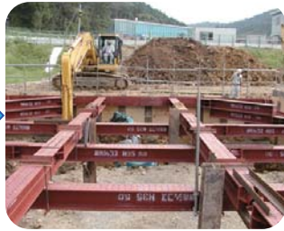
立坑の掘削開始 【2003年7月】
