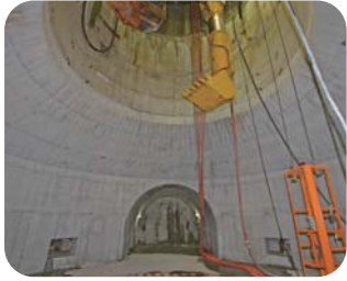
主立坑（深度500m） 【2012年3月】
