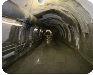
深度300m研究アクセス坑道掘削完了 【2009年3月】
