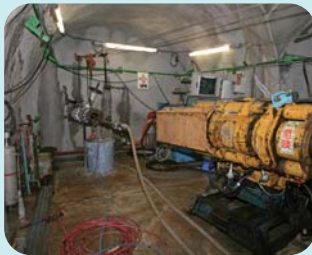
ボーリング調査
