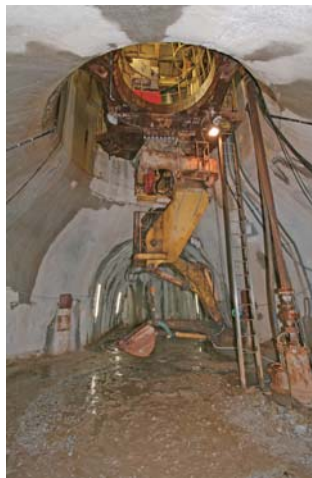
換気立坑（深度500.2m）
