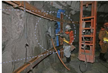
変位計と応力計の設置の様子（主立坑 深度451m）
