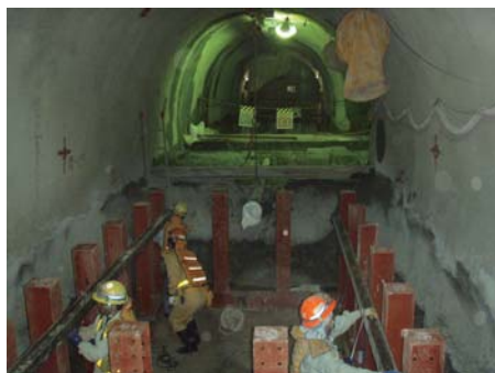
深度400m予備ステージの排水ピット設置作業
