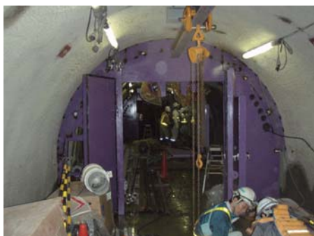
深度400m予備ステージの風門の設置作業
