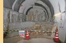
深度300mボーリング横坑（換気立坑） の地層露出部分
