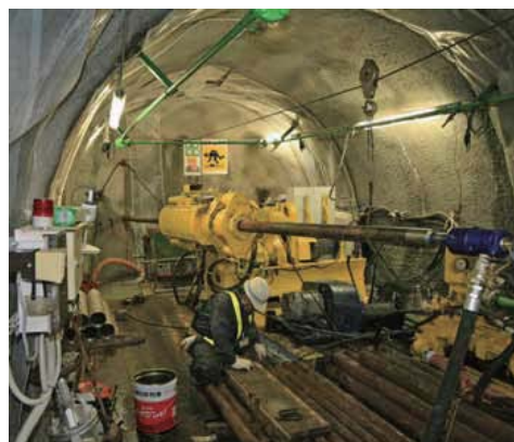
ボーリング調査 (300m避難所)
