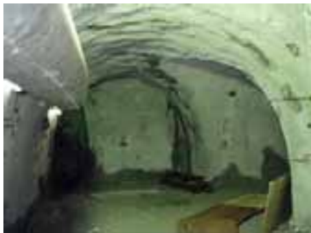
調査研究用の水平坑道の様子
