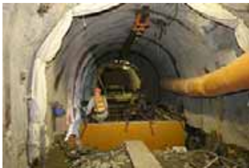
予備ステージの様子（排水ピットを設置中）
