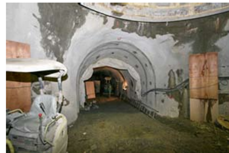
深度300mの主立坑と換気立坑をつなぐ水平の坑道の様子 （写真：主立坑側より撮影）
