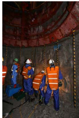
壁面観察の様子 (換気立坑：深さ約205m)
