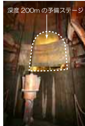
主立坑のスカフォード上から 予備ステージを見た様子
