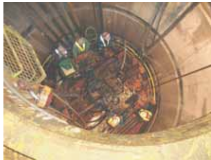
グラウチング作業の様子
