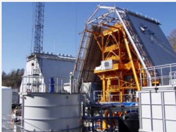
排水処理設備（写真手前の設備）と 主立坑（写真右側の建物）及び 換気立坑（写真左側の建物）の様子
