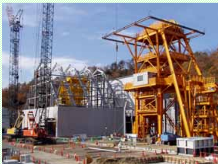
写真 左側の灰色の建物が換気立坑の防音ハウス
