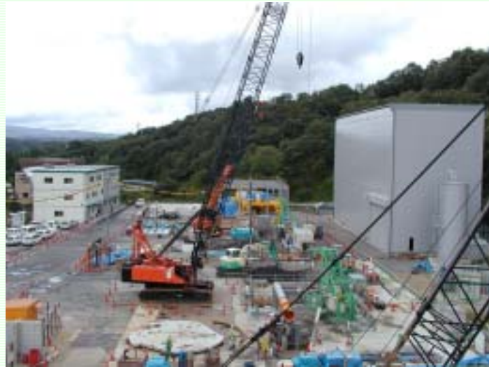
瑞浪超深地層研究所の工事の様子
