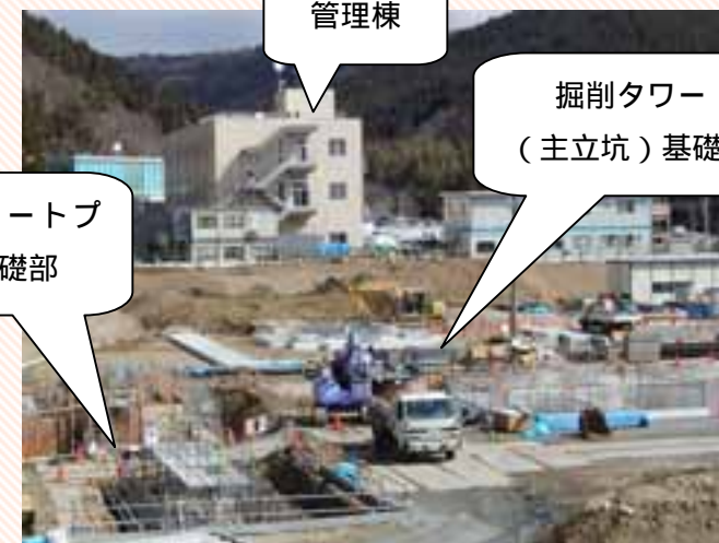
地上施設の基礎工事の様子（南から北を撮影）
