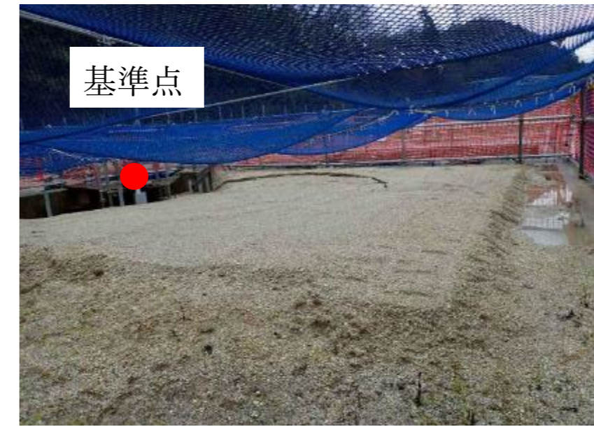
2024/3/29 換気立坑埋め戻し面
