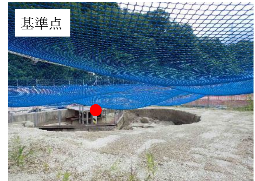
2024/7/30 換気立坑埋め戻し面
