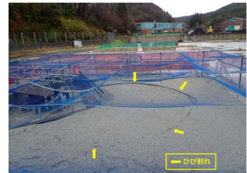
2024/3/29 換気立坑埋め戻し面
