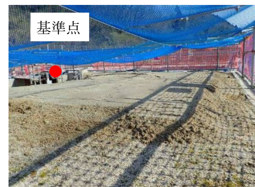
2024/3/15 換気立坑埋め戻し面
