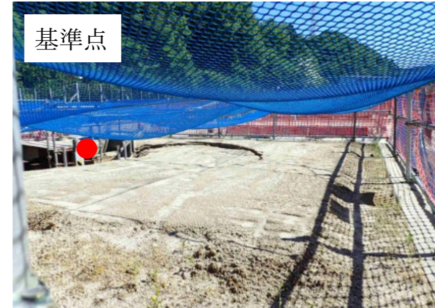
2024/5/14 換気立坑埋め戻し面
