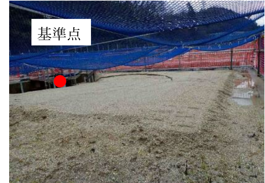
2024/3/29 換気立坑埋め戻し面
