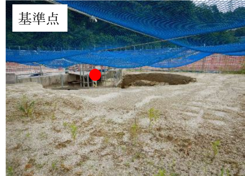
2024/7/10 換気立坑埋め戻し面
