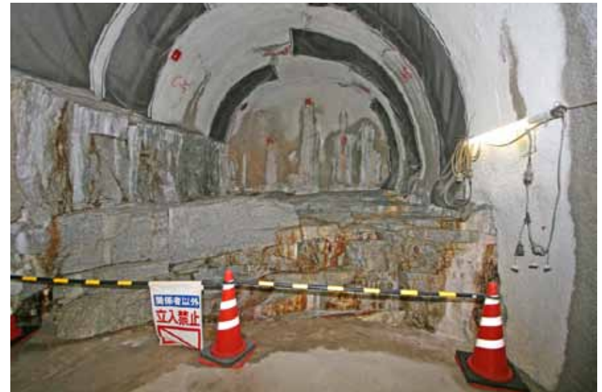
深度300mボーリング横坑（換気立坑側） の地層露出部分
