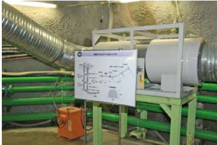
深度300m研究アクセス坑道(主立坑エレベータ付近) 『深度300mステージレイアウト説明パネル』
