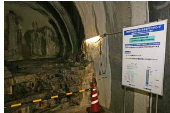
深度300mボーリング横坑(換気立坑) 『水圧モニタリング説明パネル』
